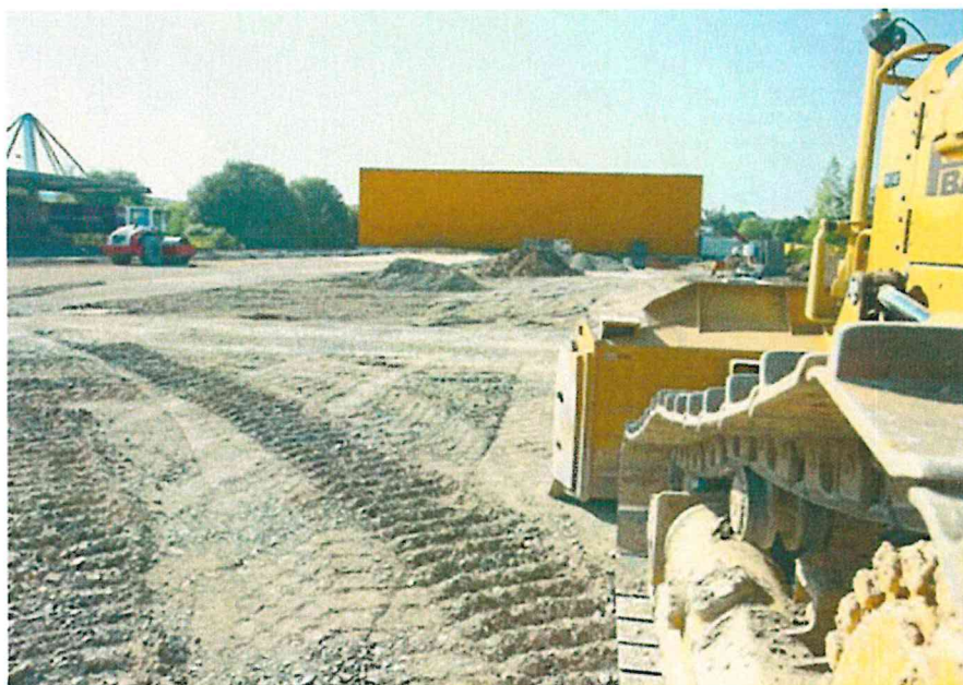
Für die neue Lagerhalle von Defru in Glauchau laufen die Fundament-Arbeiten.
